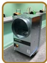
L'assainissement de l'air a été renforcé par une nouvelle extraction qui s'est rajouté à celle existante faisant passer à 3250m<sup>3</sup>/h l'aspiration des vapeurs de plomb. Le jour où une réglementation s'imposera, nous n'aurons plus qu'à ajuster notre dispositif (mai 2021, société SAJECLIM environ 10 000 €).
